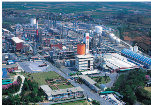
▶ LG생활건강 나주공장 전경
